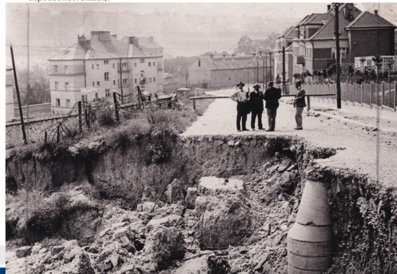
Foto 5-24. Zajišťovací práce na svahu zahrady Na Valech (zdroj: Archiv Pražského hradu, stavební deník, zahrada Na Valech, rok 1926; autorem fotografie pořízené ze zahrady malostranského paláce Schützenů čp. 171 je pravděpodobně J. Blažek).
