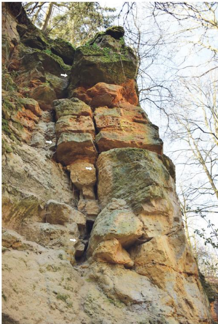
Foto 7-47. Vertikálními trhlinami oddělený pilíř výšky přibližně 8 m (viz šipky) v jižní stěně přírodní památky Housle v Lysolajích poblíž uzávěru rokle (J. Novotný, 26. 3. 2024).
