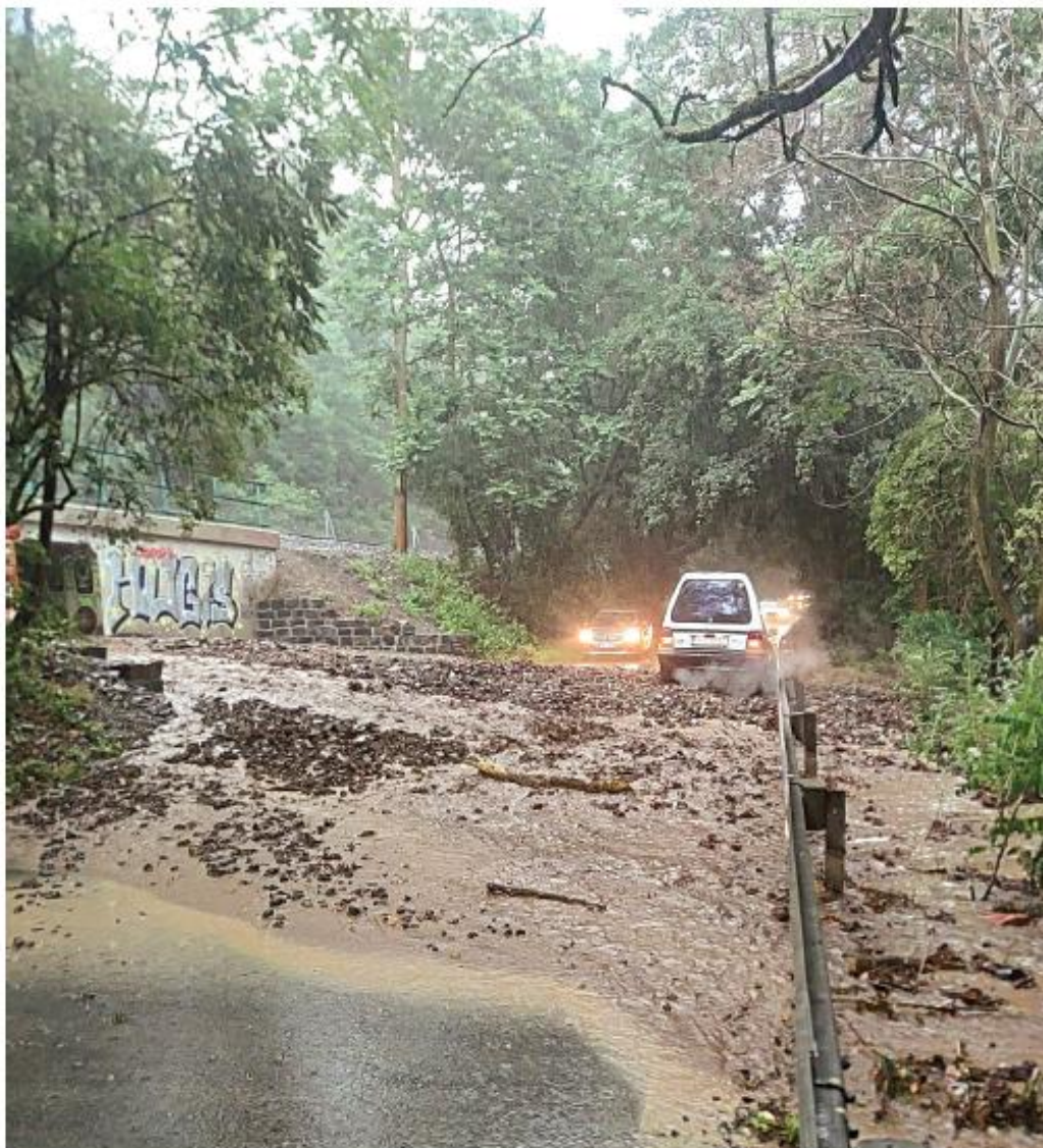
Foto 6-7. Akumulace přívalového proudu z 27. června 2024 na silnici III/1043 zaznamenaná bezprostředně po prudké bouři ve staničení km 35,570 na železniční trati v úseku Praha-Zbraslav a Dolní Břežany-Jarov (J. Pfeffer, 27. 6. 2024).
