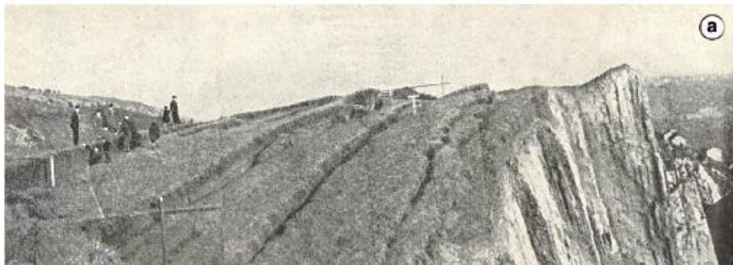
Foto 5-16. Pohled na propagaci zátrhů za původní odlučnou hranou svahové deformace v lomu Vysoká v Hlubočepch; a – stav z 21. listopadu 1939 (Kettner 1941), b – stav z 24. března 1940 (Kettner 1941), c – stav z 3. března 2022 (J. Novotný, 3. 3. 2022).
