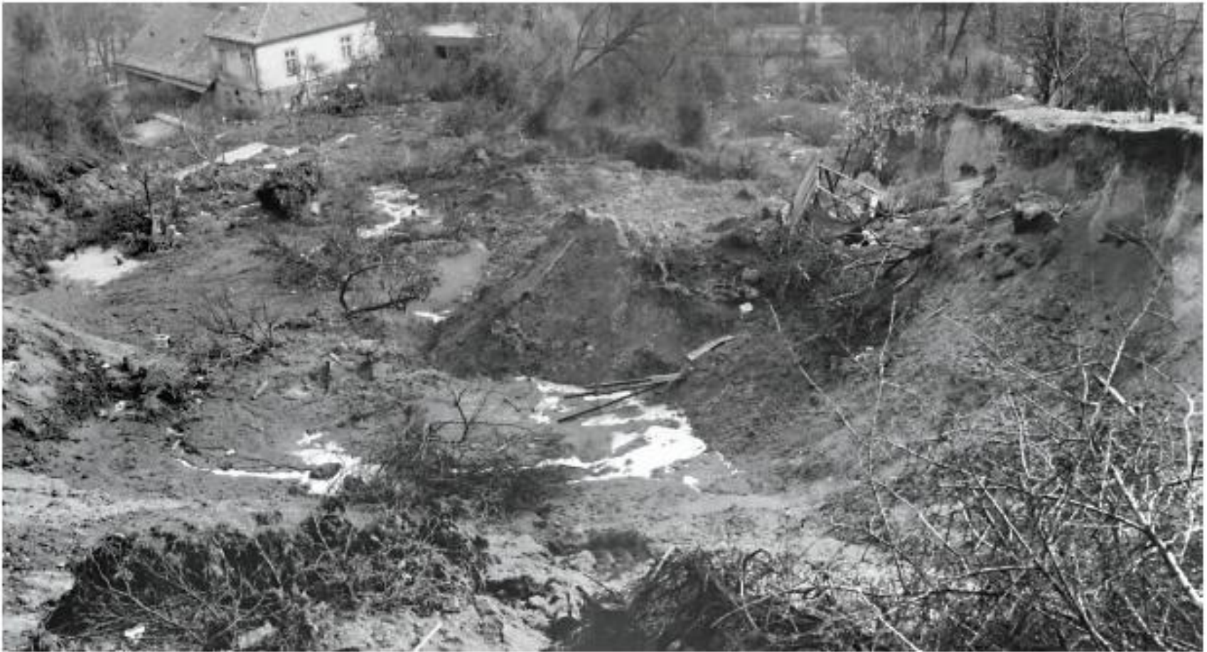
Foto 8-2. Ještě několik dnů po aktivaci sesuvu Nikolajka vytékala voda z prasklého vodovodního potrubí a sytila koryto sesuvu a jeho akumulaci. Na fotografii z prosince 1981 jsou patrné zamrzlé vodní plochy a celkově rozbahněný povrch sesuvu přitékající vodou (J. Rybář, 1981).
